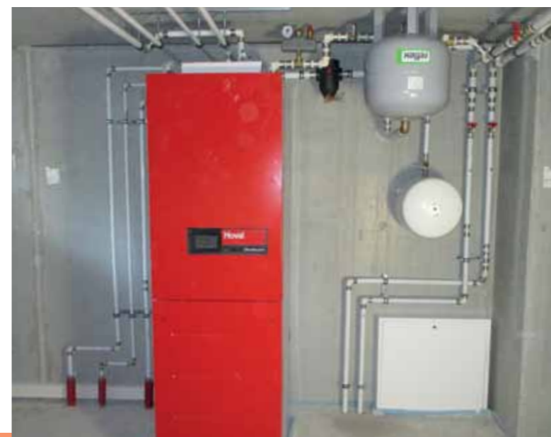
Blitzsaubere Installation einer Wärmepumpe durch prosermo
