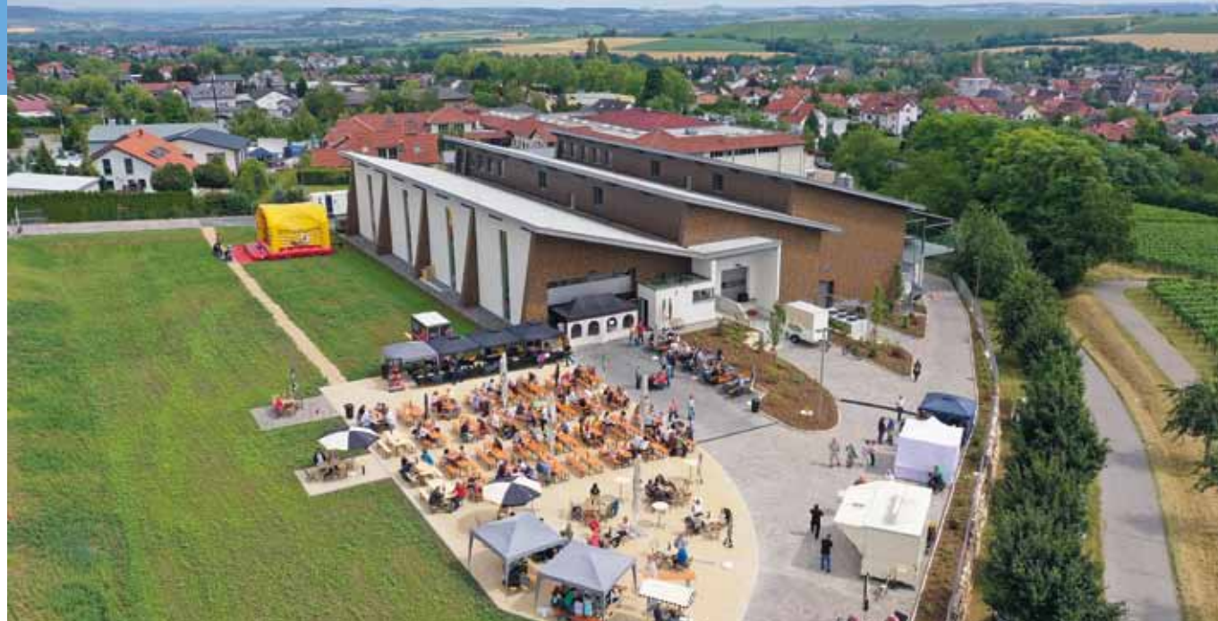
Im Juli 2019 wurde die letzte Erweiterung in der Schafhohle erfolgreich abgeschlossen.
