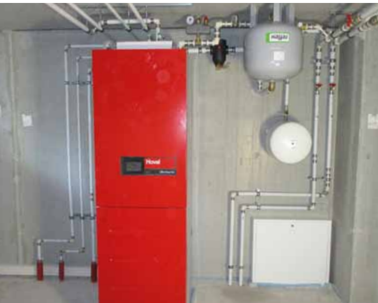
Blitzsaubere Installation einer Wärmepumpe durch prosermo
