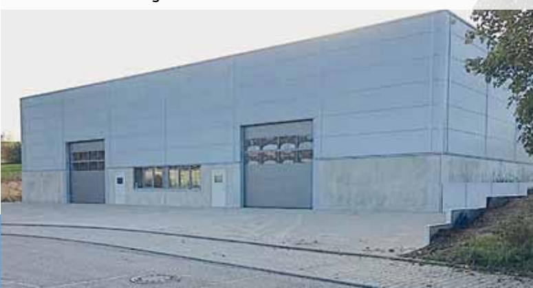
Erweiterung unserer Firma mit Hallenneubau
