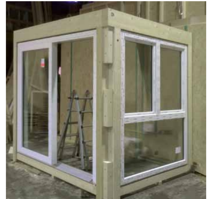
Vormontage in der Halle: Wände samt Fenster ohne Dach
