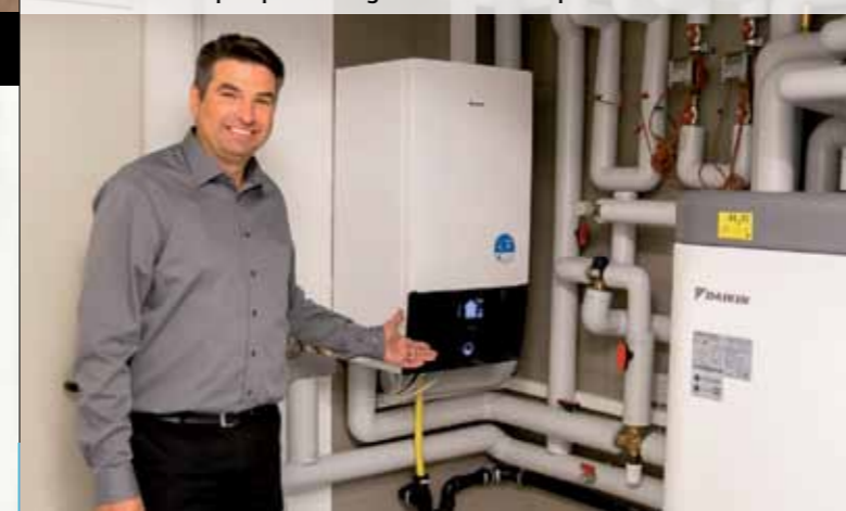
Wärmepumpen-Innengerät und Wärmespeicher
