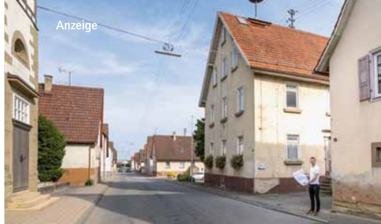
Die Sanierung der Ortsmitte Nordhausen ist das nächste große Bauprojekt.
