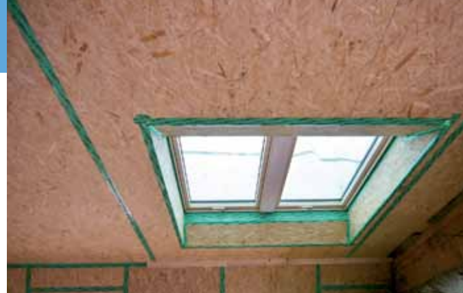
Deckenelement mit Dachfenstern
