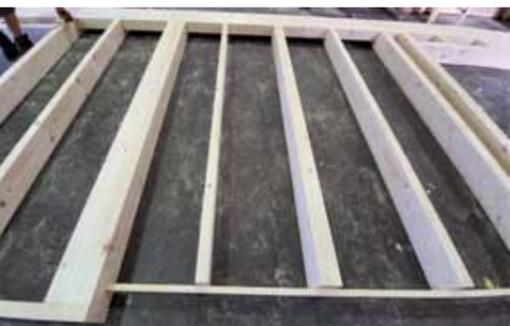
Damit die Zwischenräume mit Dämmmaterial gefüllt werden können, wird zunächst die Innenseite mit OSB-Platten beplankt. Dabei werden die Platten auf Maß zugesägt. Die OSB-Platten wirken zudem als aussteifendes statisches Element.
