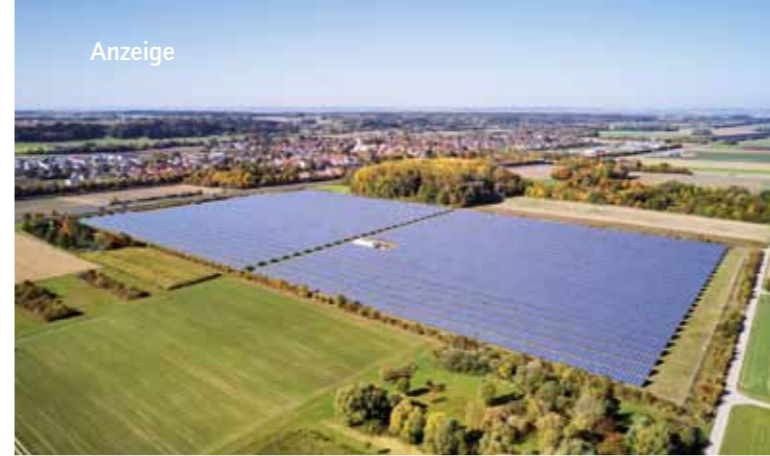
Solarpark Nordendorf: einer der ersten deutschen Solarparks von hep
