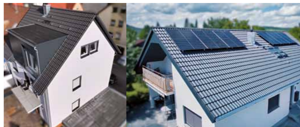
Beispiele für Dachsanierung von Holzbau Stopper
