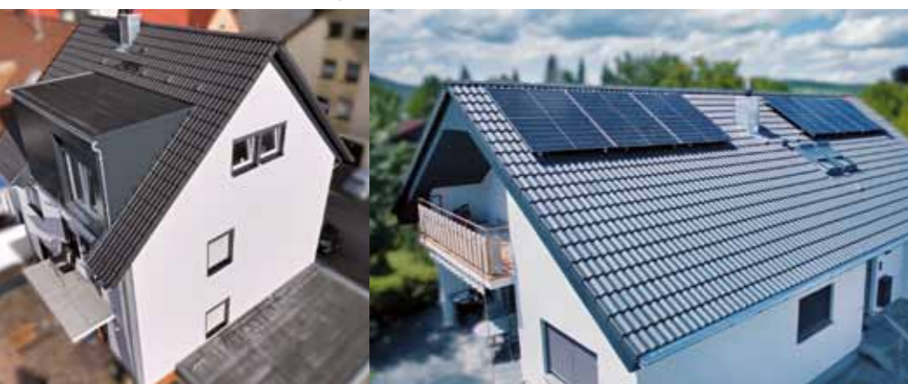
Beispiele für Dachsanierung von Holzbau Stopper
