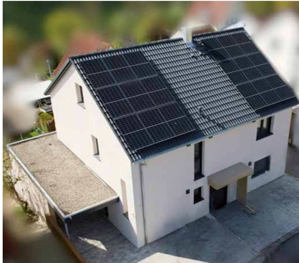
Das sanierte Dach und das verlängerte Garagendach
