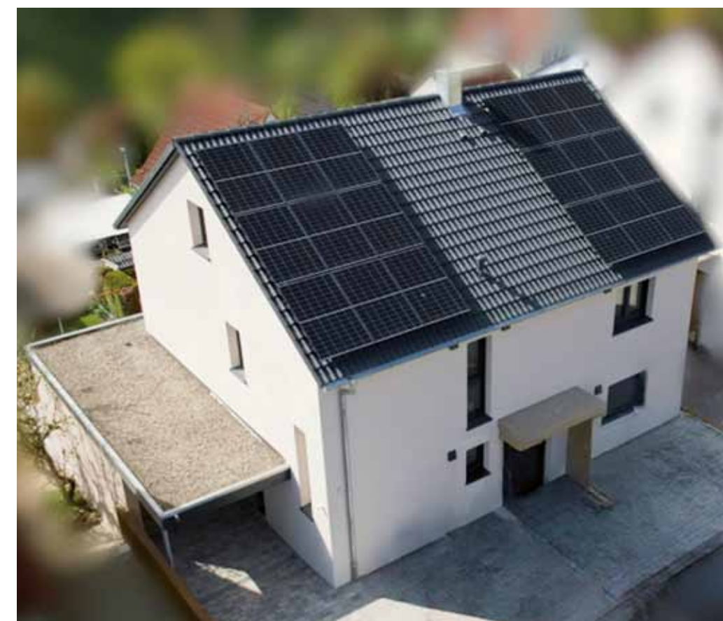
Das sanierte Dach und das verlängerte Garagendach
